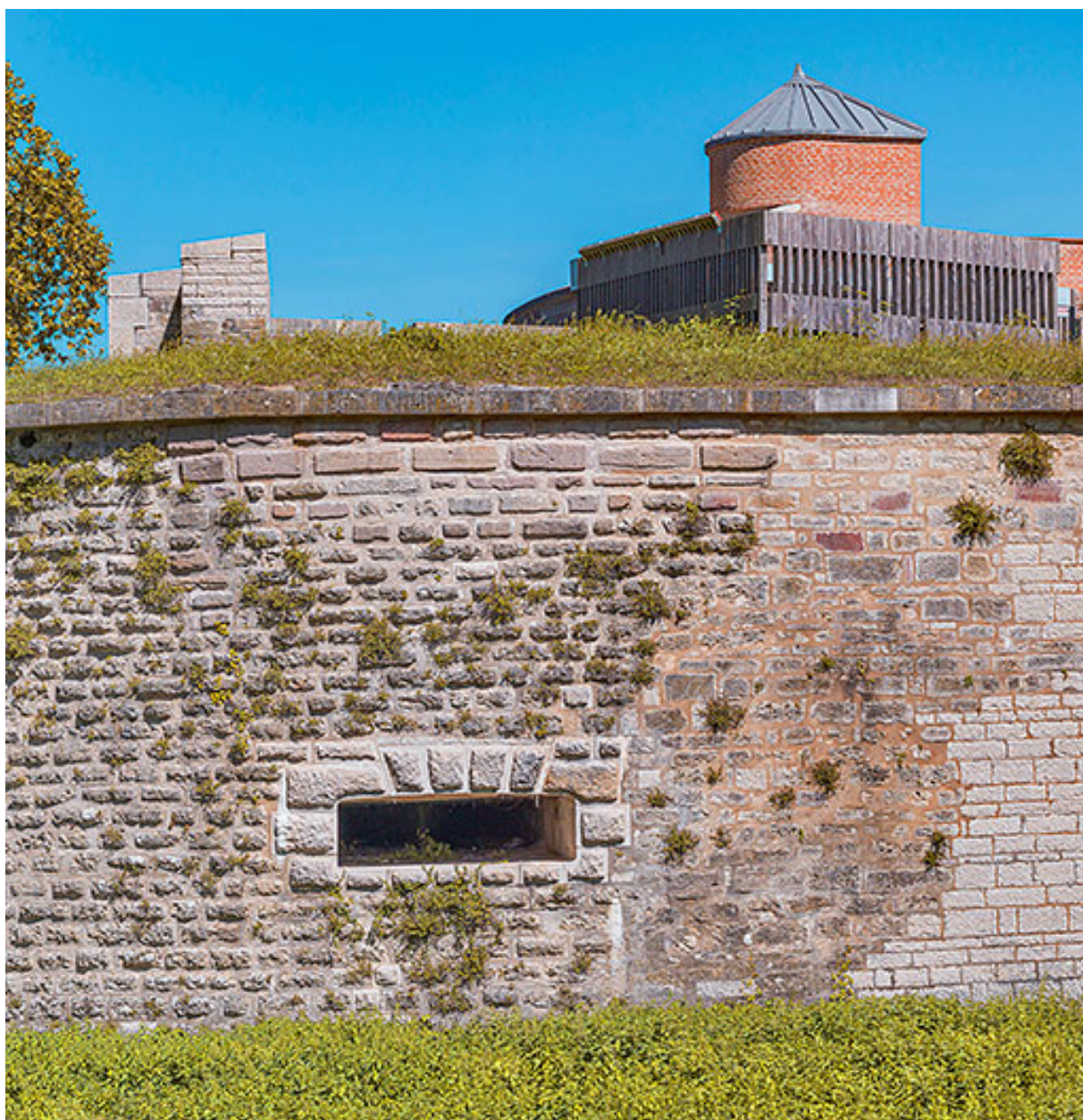
La tour basse des moulins du château.
