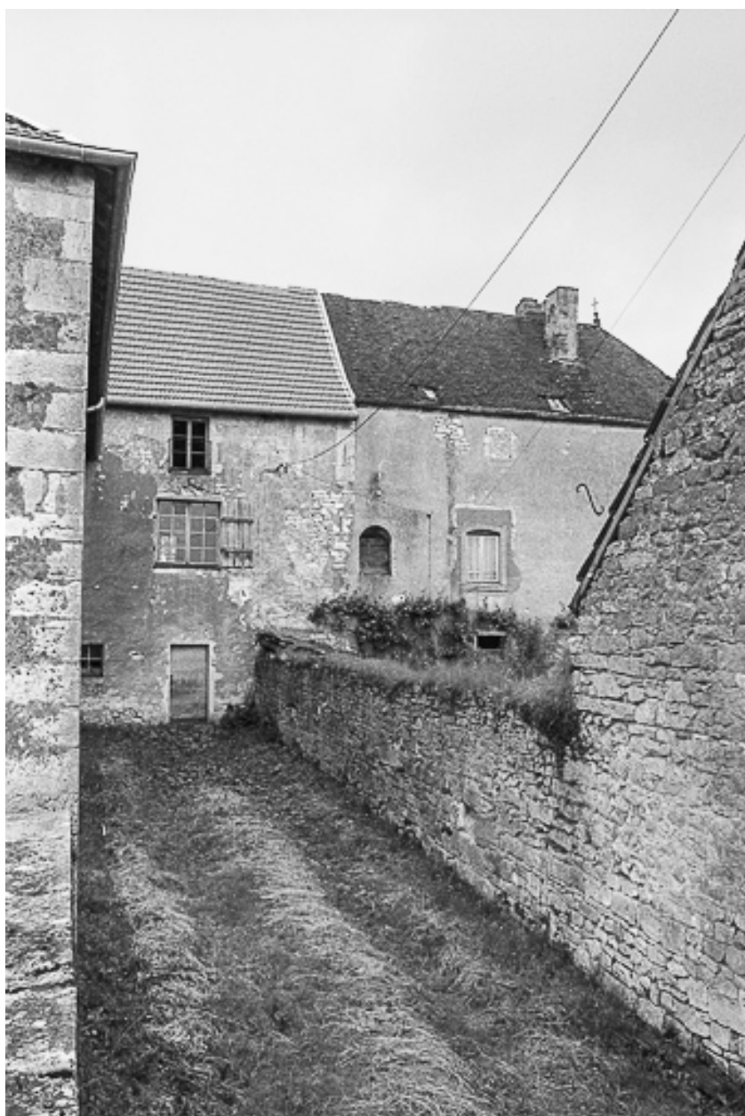
Vue des bâtiments à droite de l'église.
