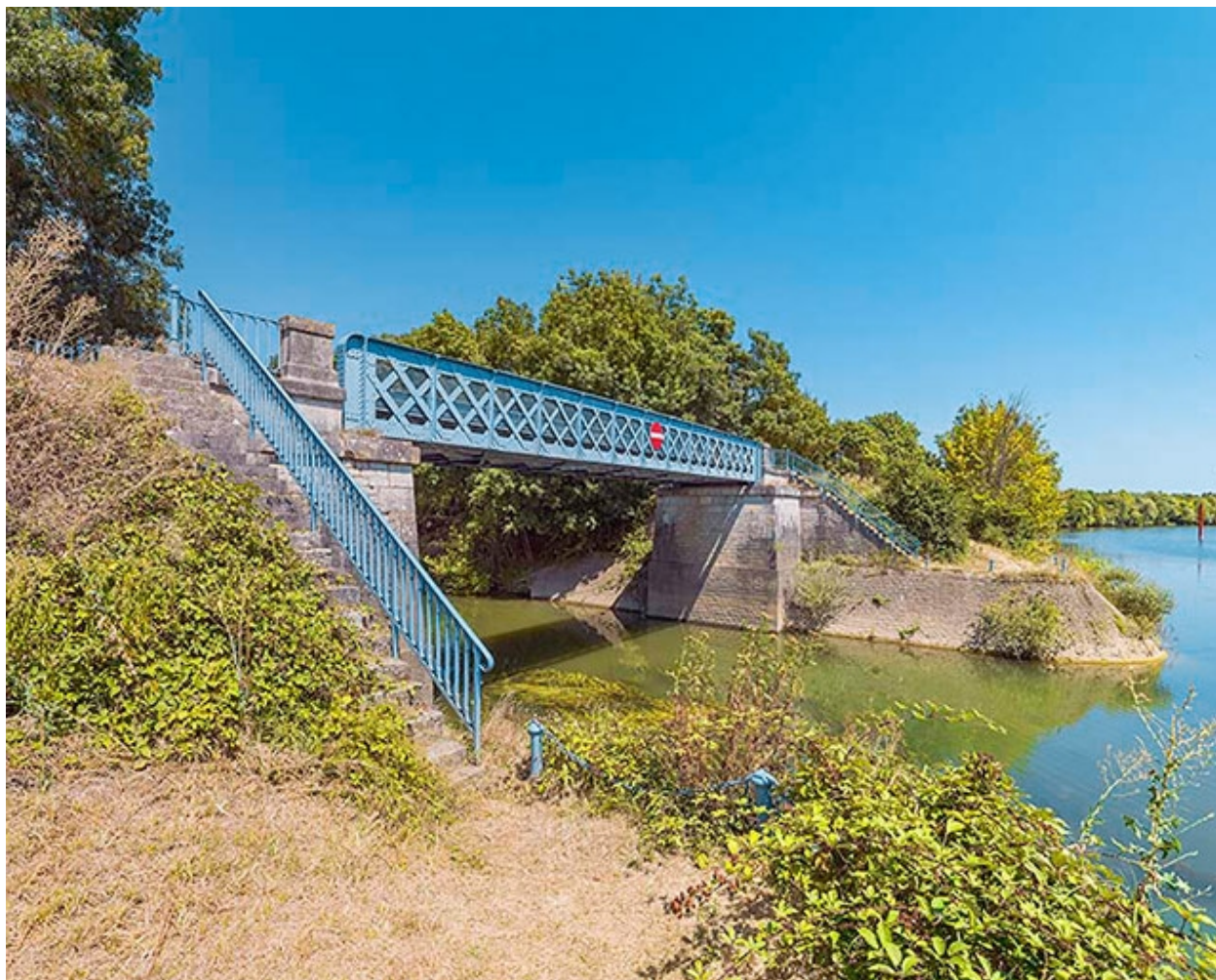
Vue d'ensemble du pont sur la Dheune.
