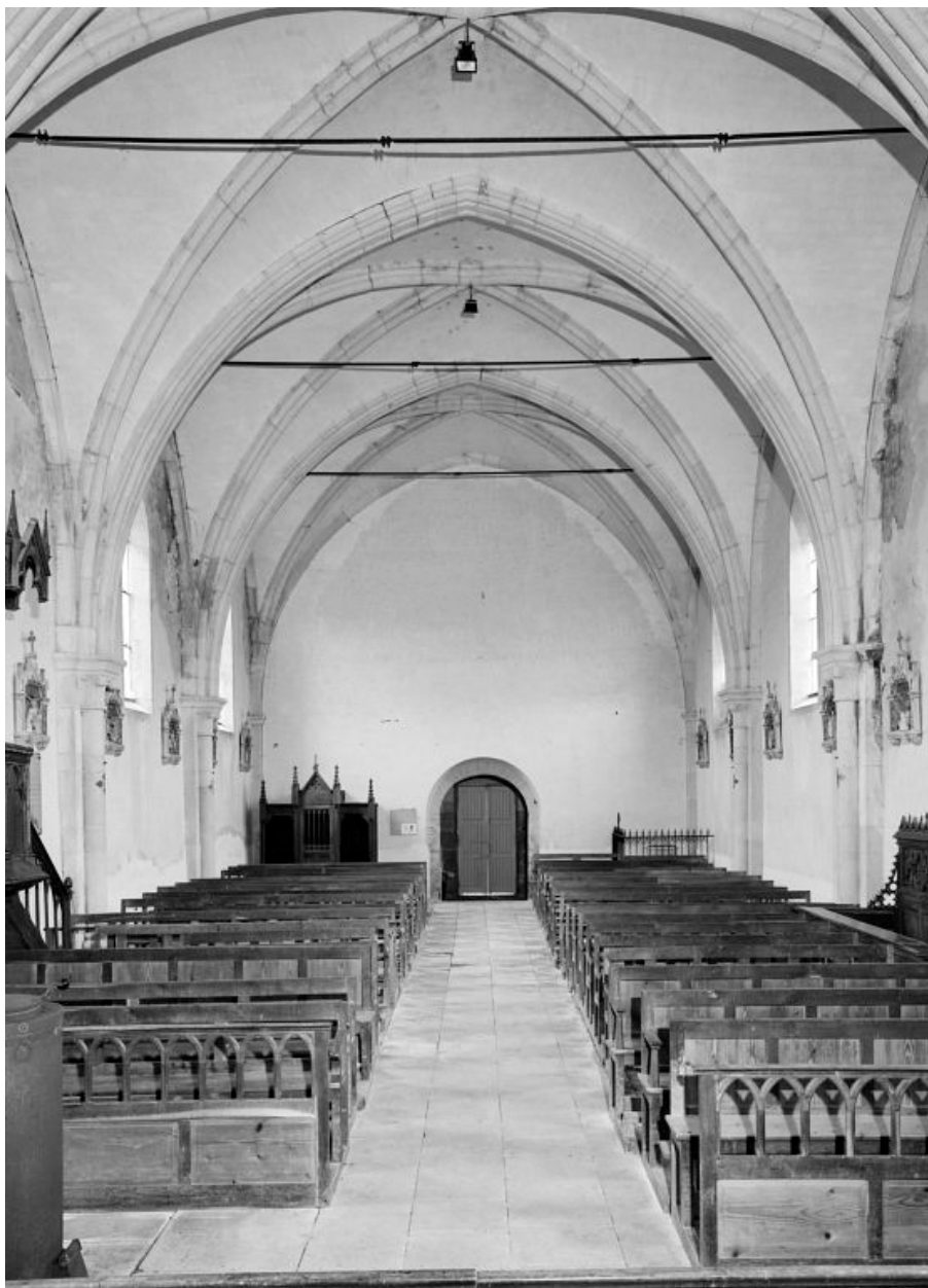
Vue intérieure prise du chœur.
