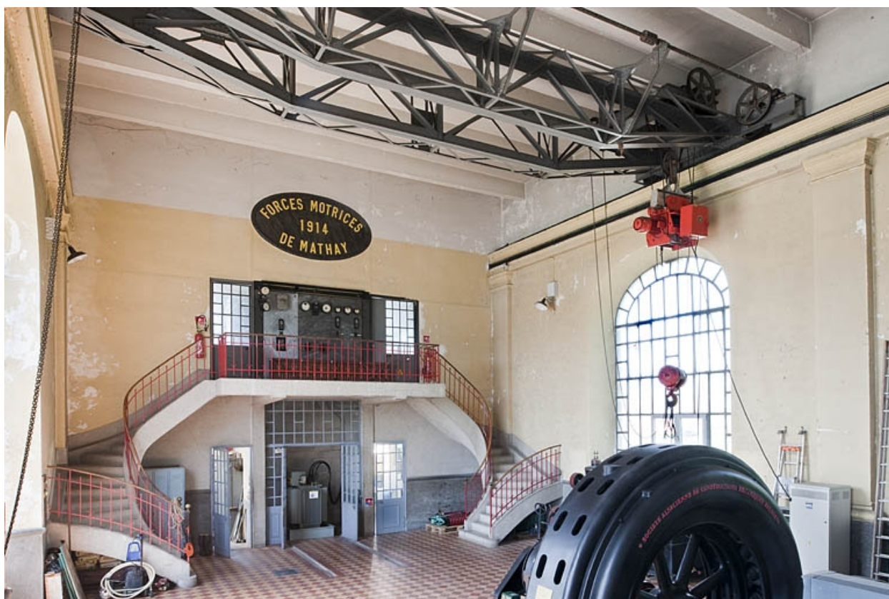
Centrale hydroélectrique de Mathay : intérieur.
