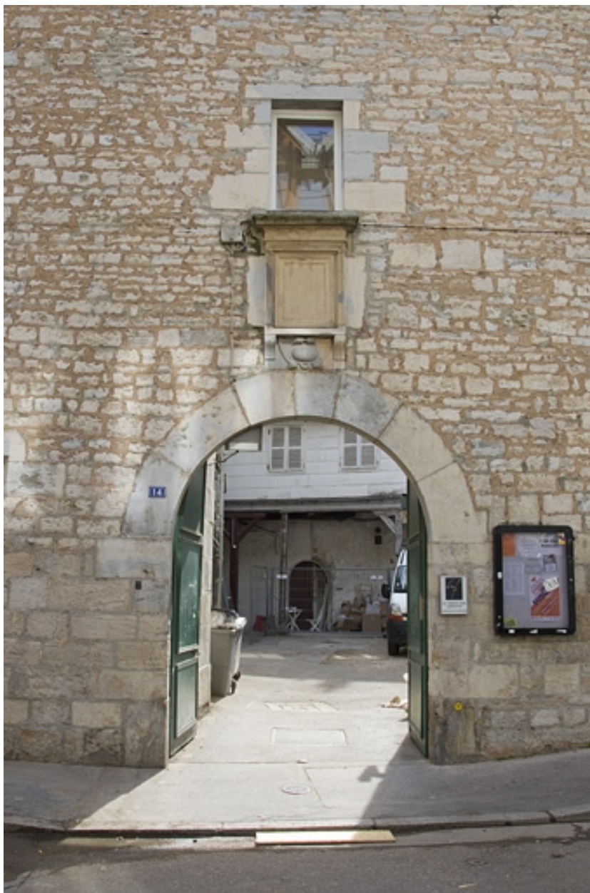
Façade latérale droite : détail du portail d'entrée.
