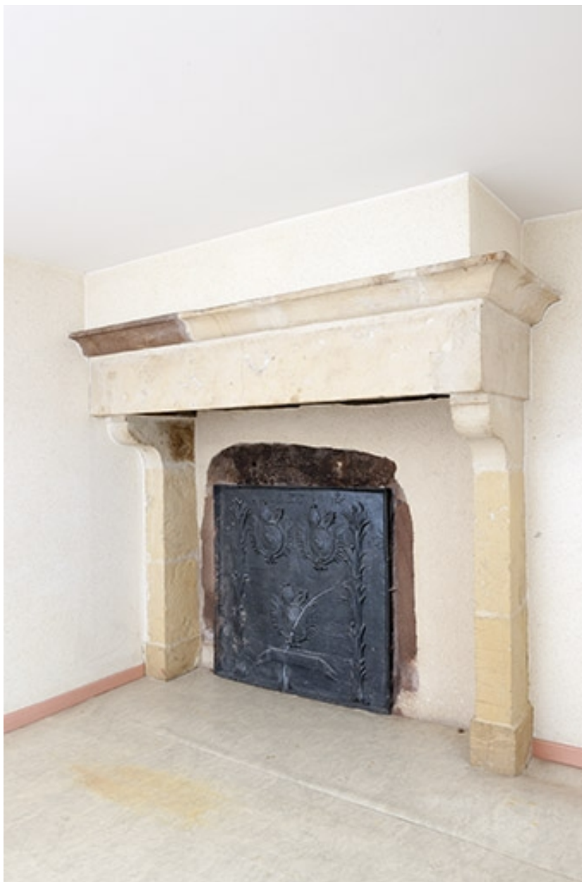
La cheminée de la cuisine.
