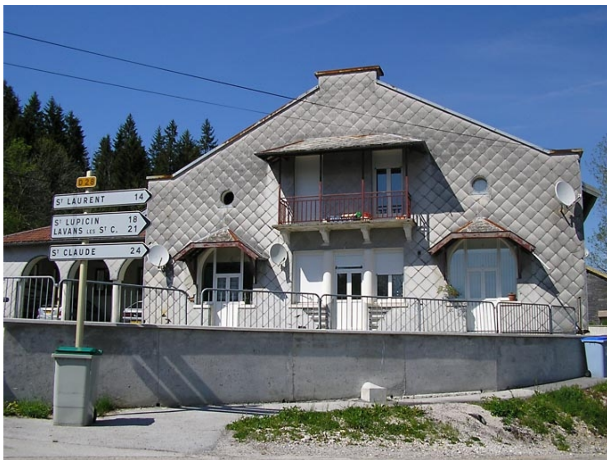
Le pignon sud-ouest et l'ancien préau.
