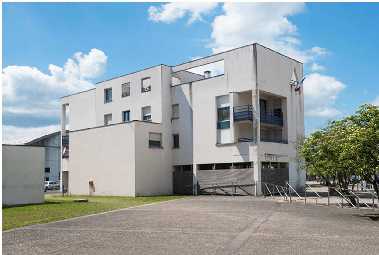
Angle sud-est des logements ouest.
