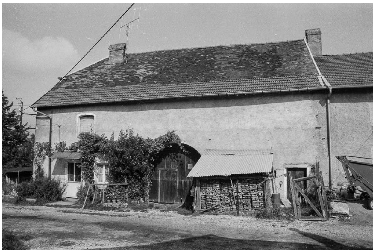
Façade antérieure : partie gauche.
