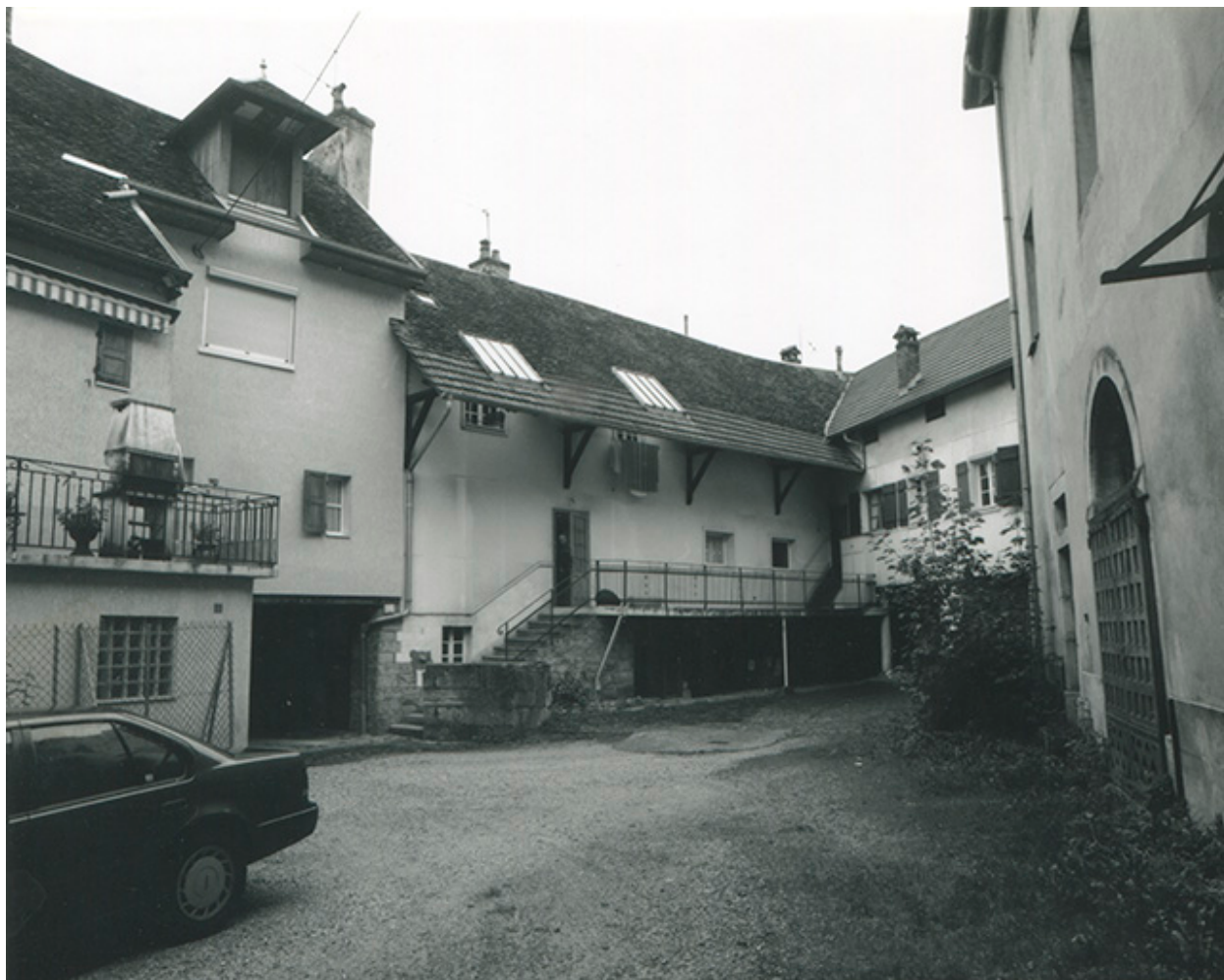
Grande cour. Vue depuis l'ouest, 1997.
