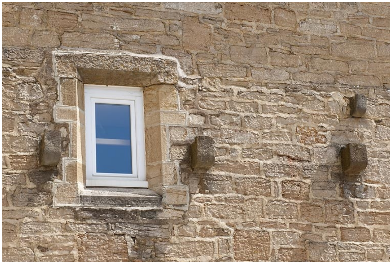
Chapelle (D), vue d'une baie.
