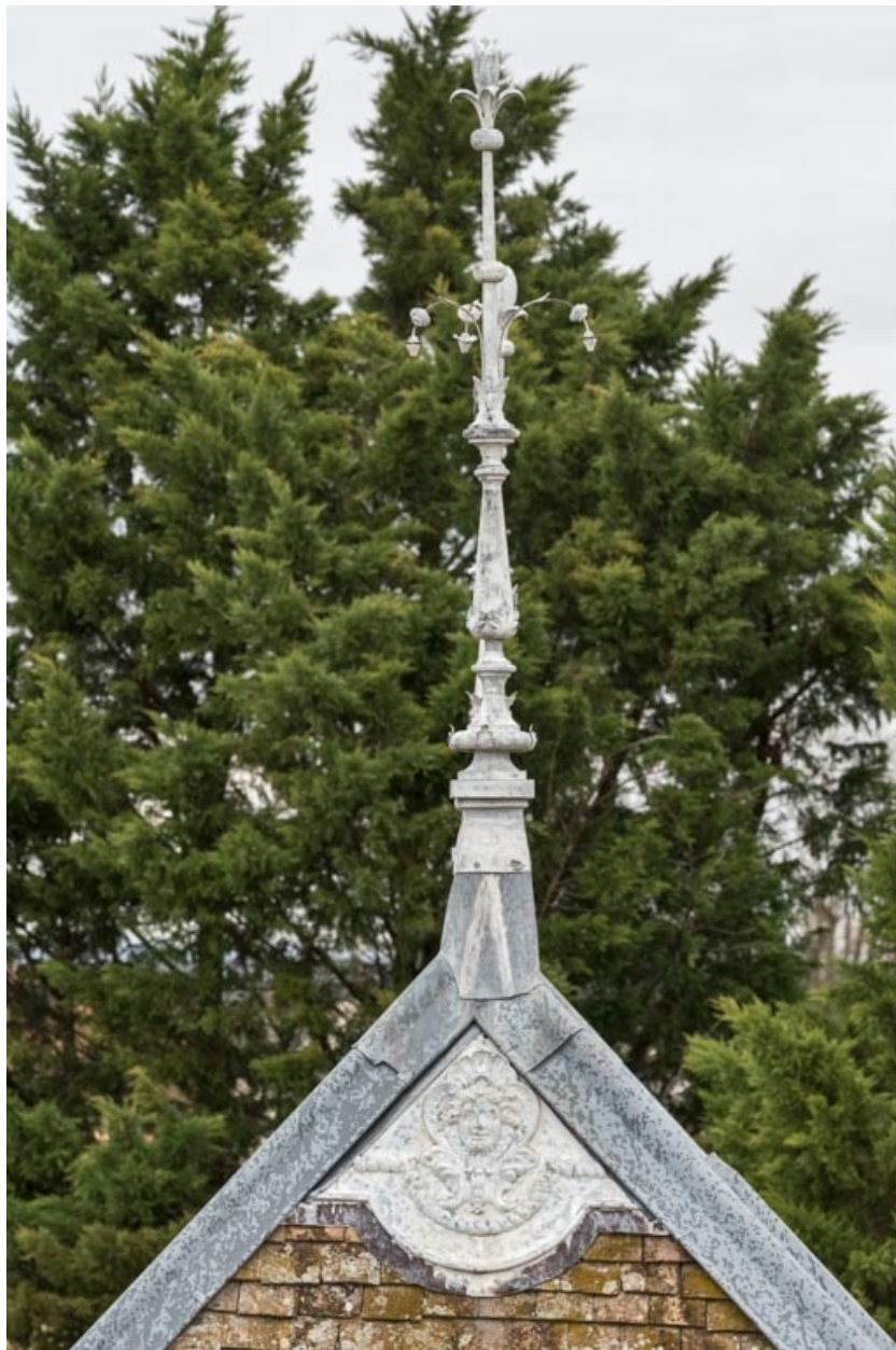
Epis de faîtage sur le corps nord.
