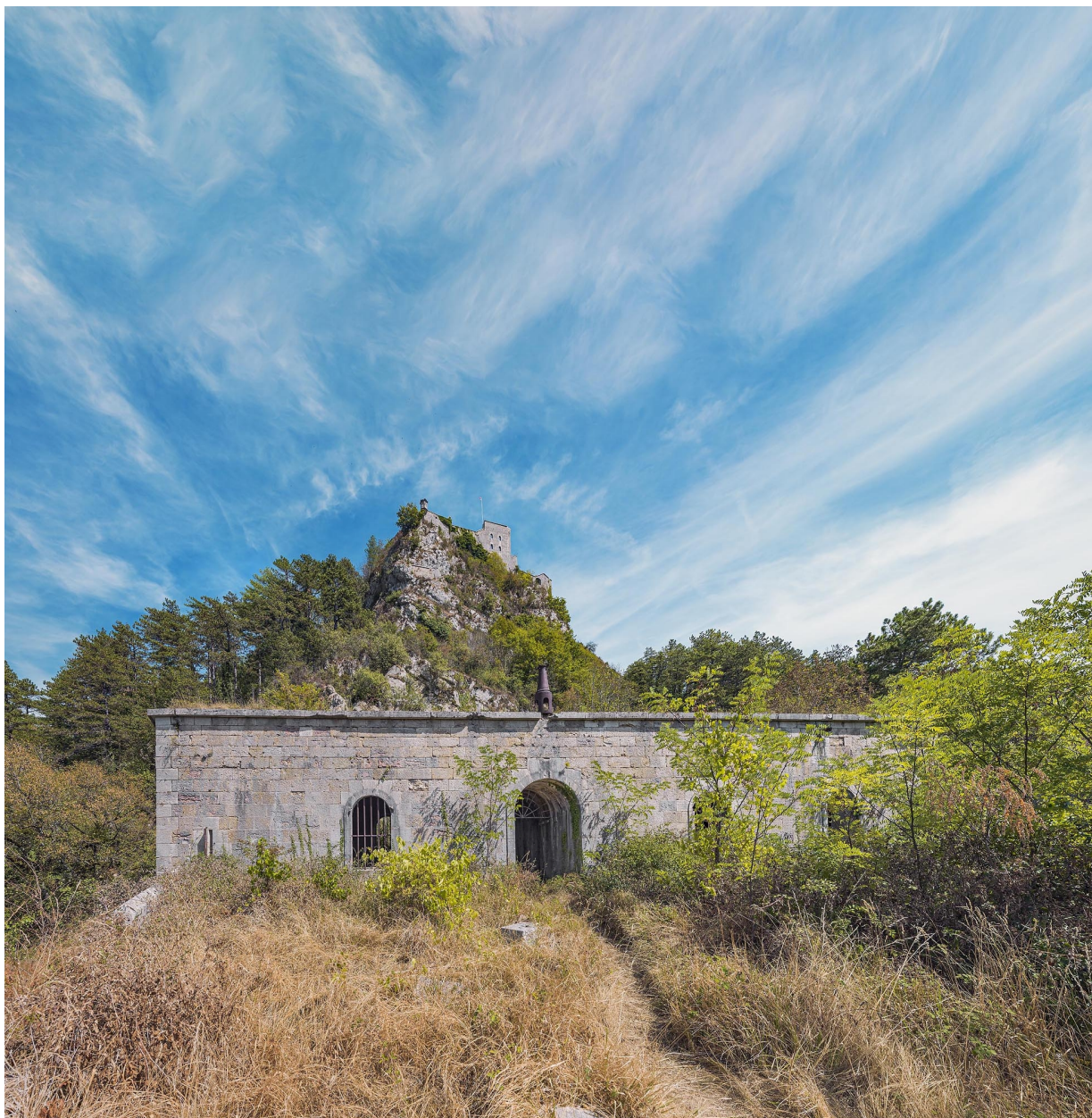
Le bâtiment casematé : la façade antérieure.
