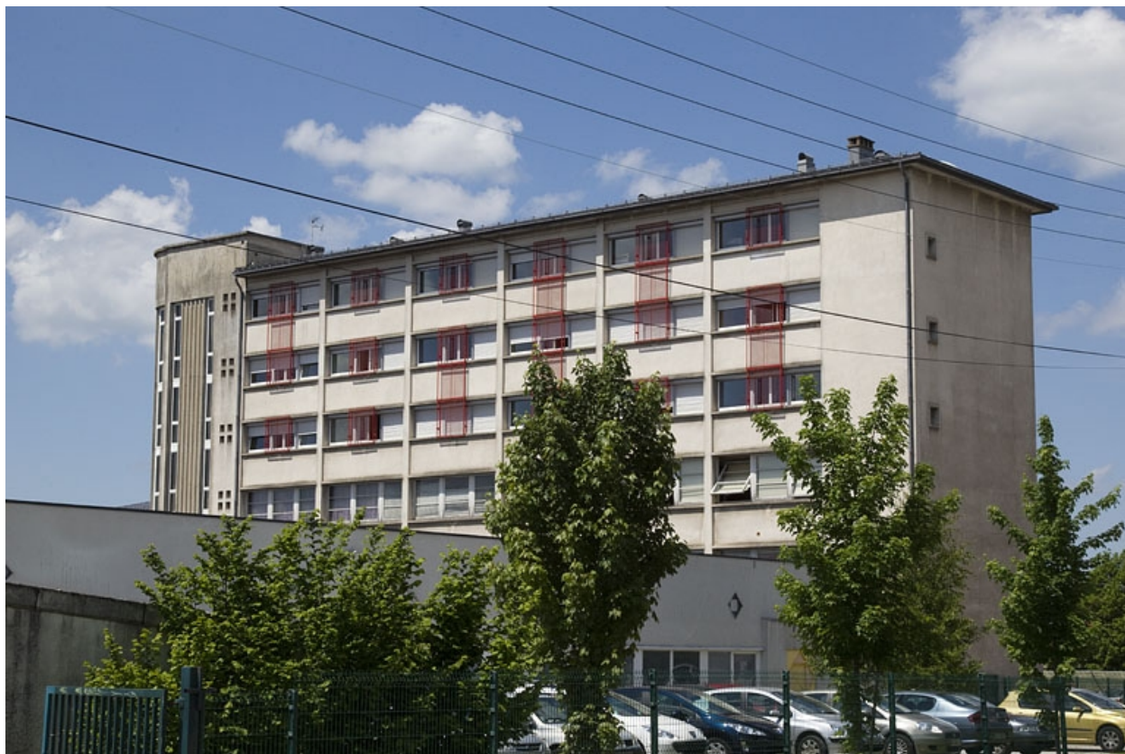
Internat garçons, vu du sud.
