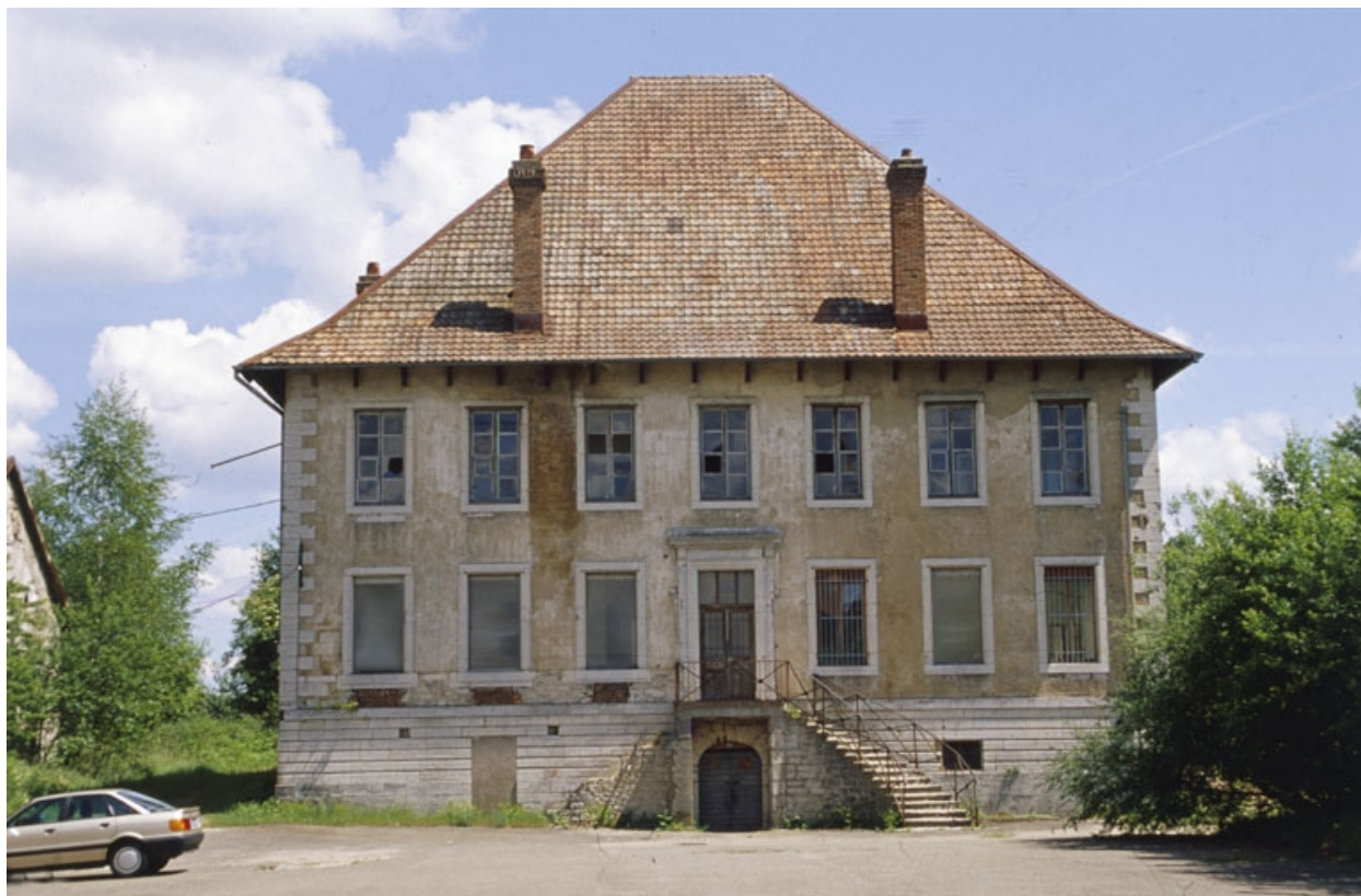
Façade antérieure du château.
