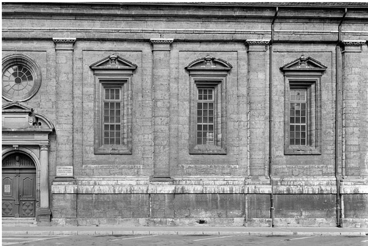
Façade sud, travées de droite.
