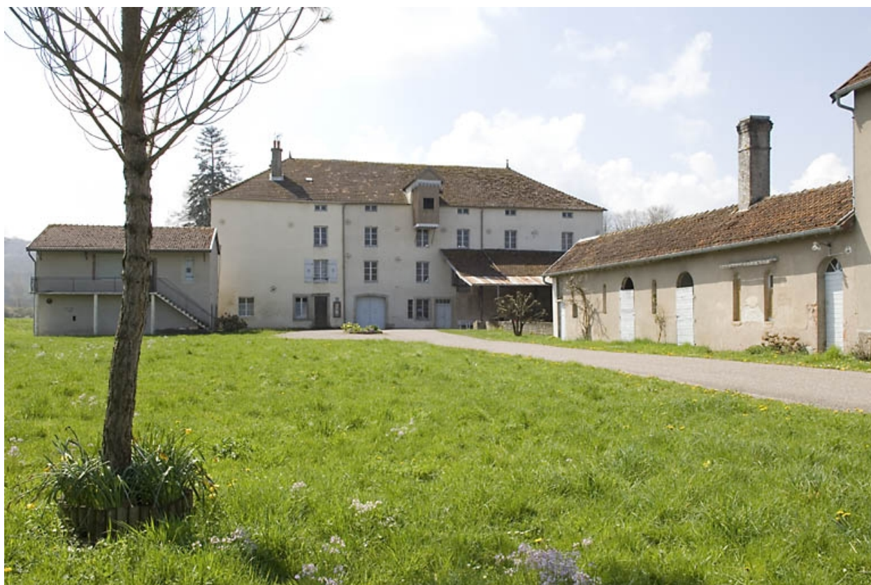
Façade antérieure et dépendances depuis l'entrée.
