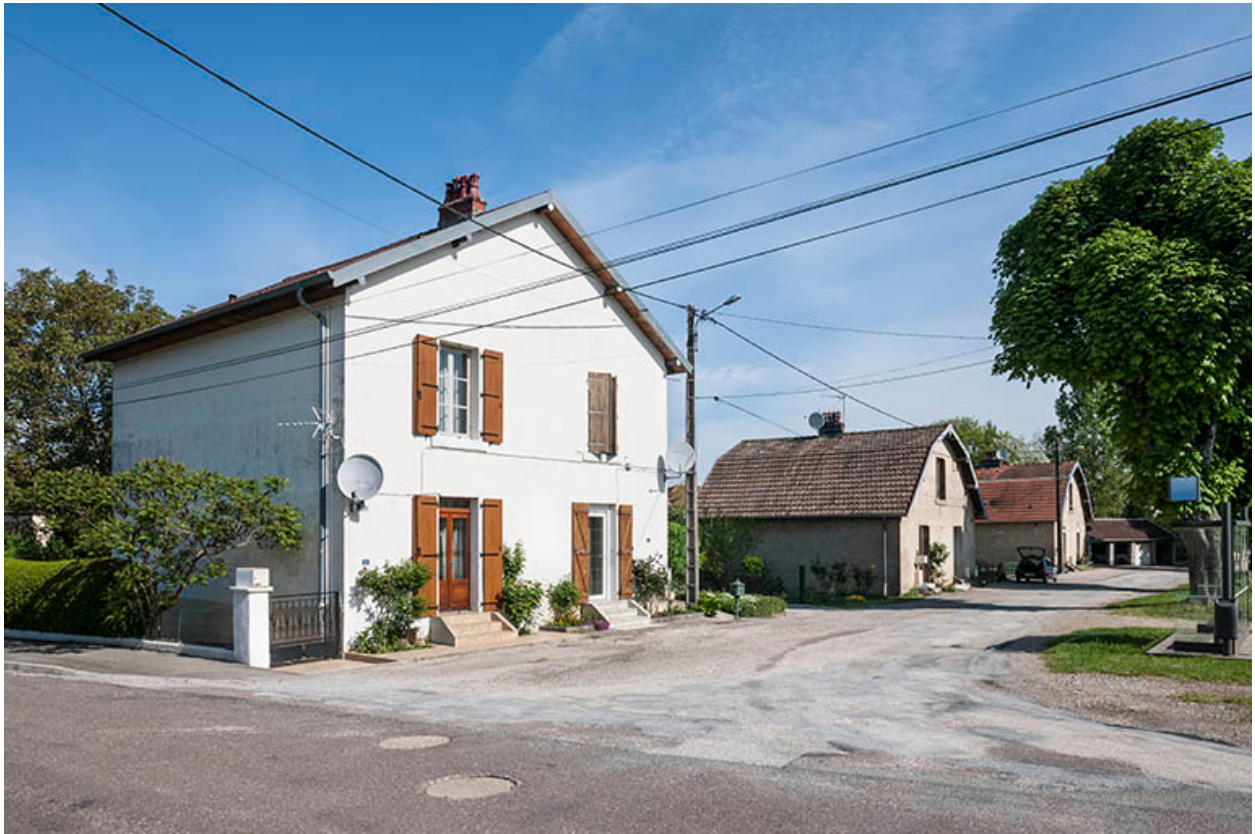
Logements ouvriers (4 à 10 allée des Rompeux).
