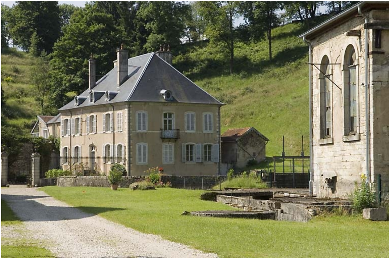
Logement patronal vu de trois quarts.
