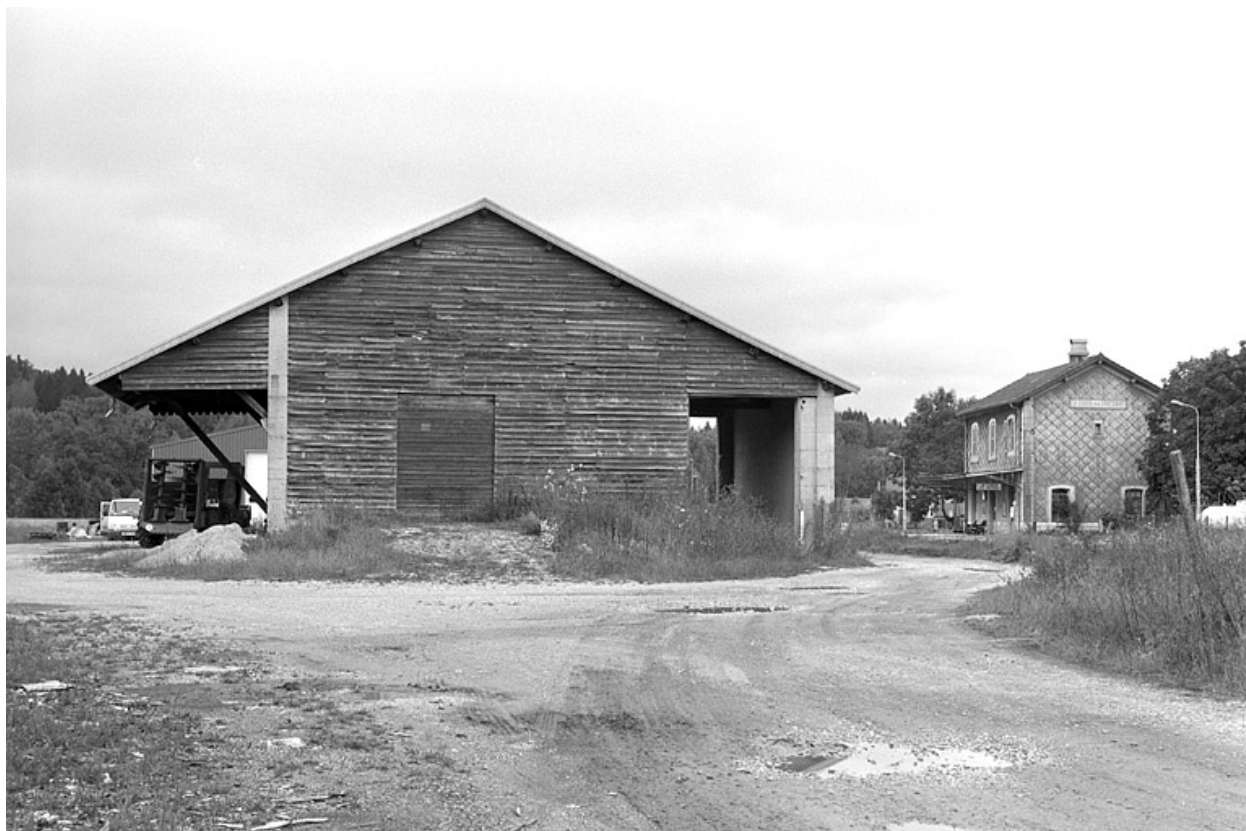
Entrepôt : façade postérieure (sud).
