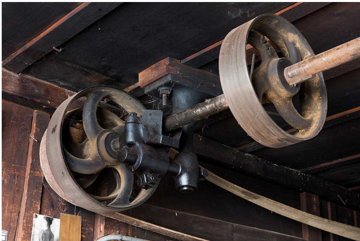
Atelier : transmission au plafond.
