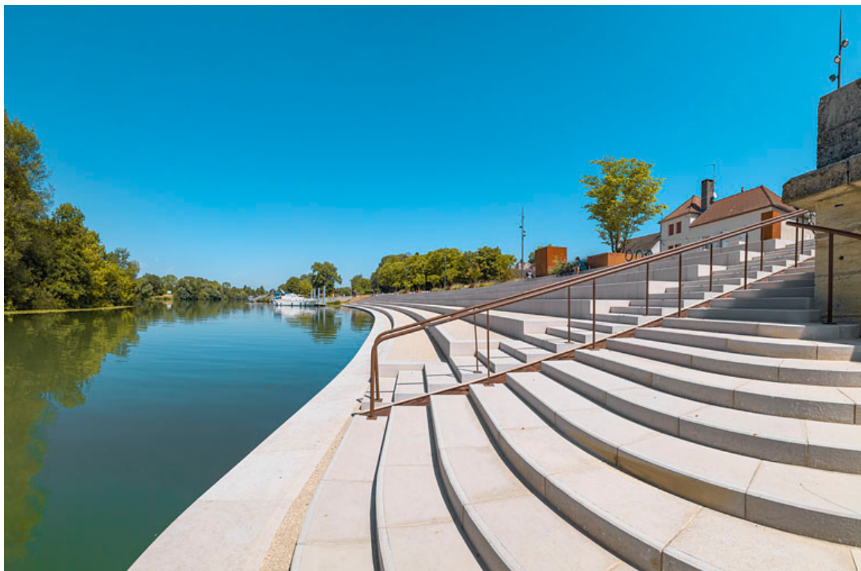
Vue d'ensemble des quais après leur réaménagement.
