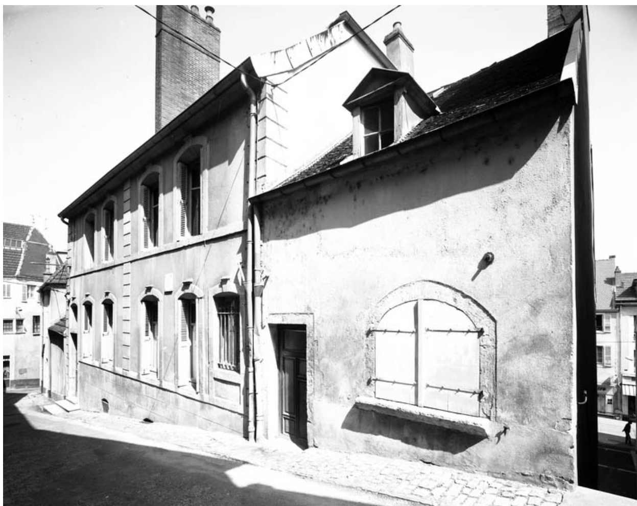
Maison située 8 et 8bis rue de la Malcouverte.
