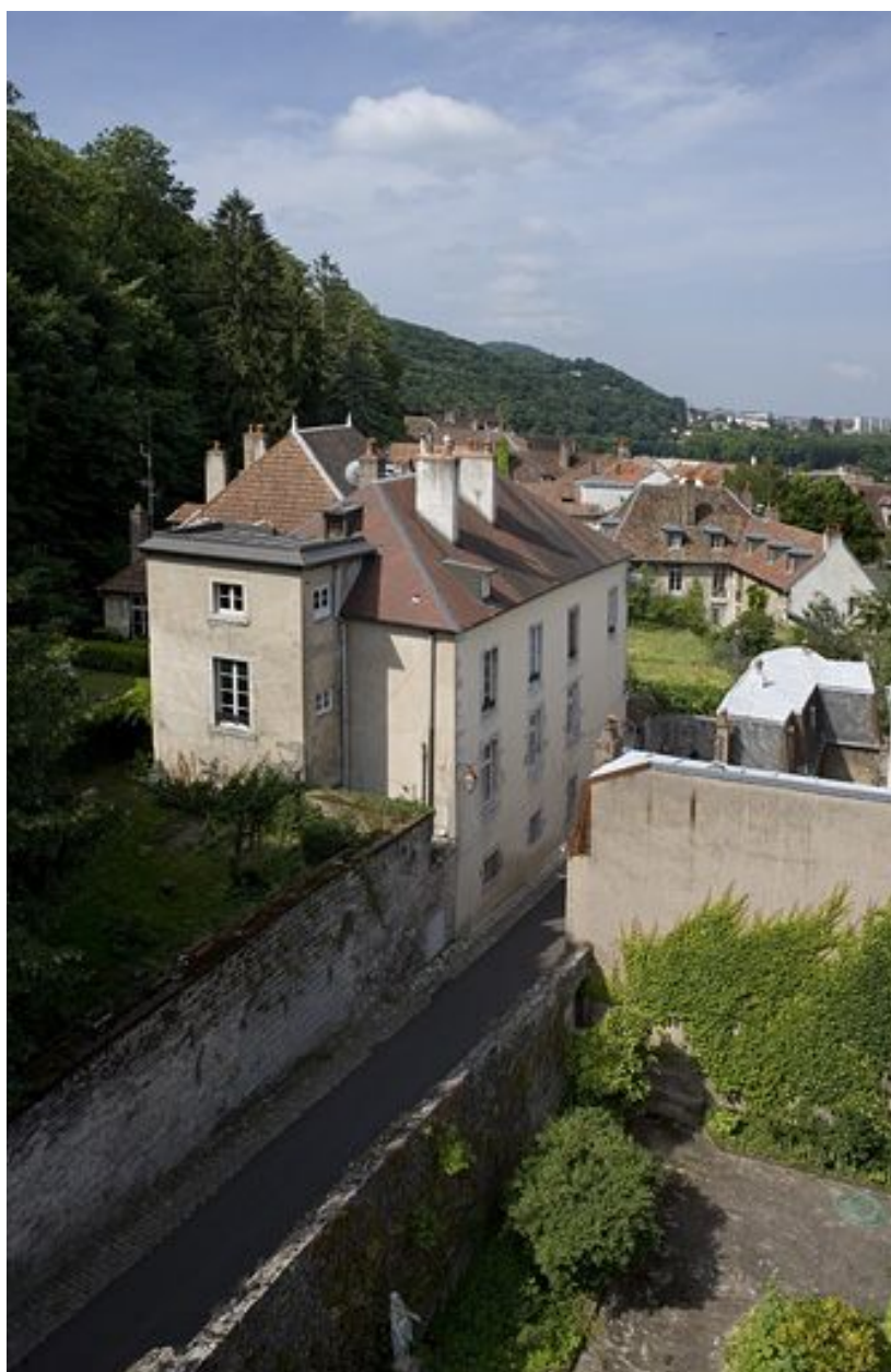
Vue d'ensemble depuis les locaux du CRDP.
