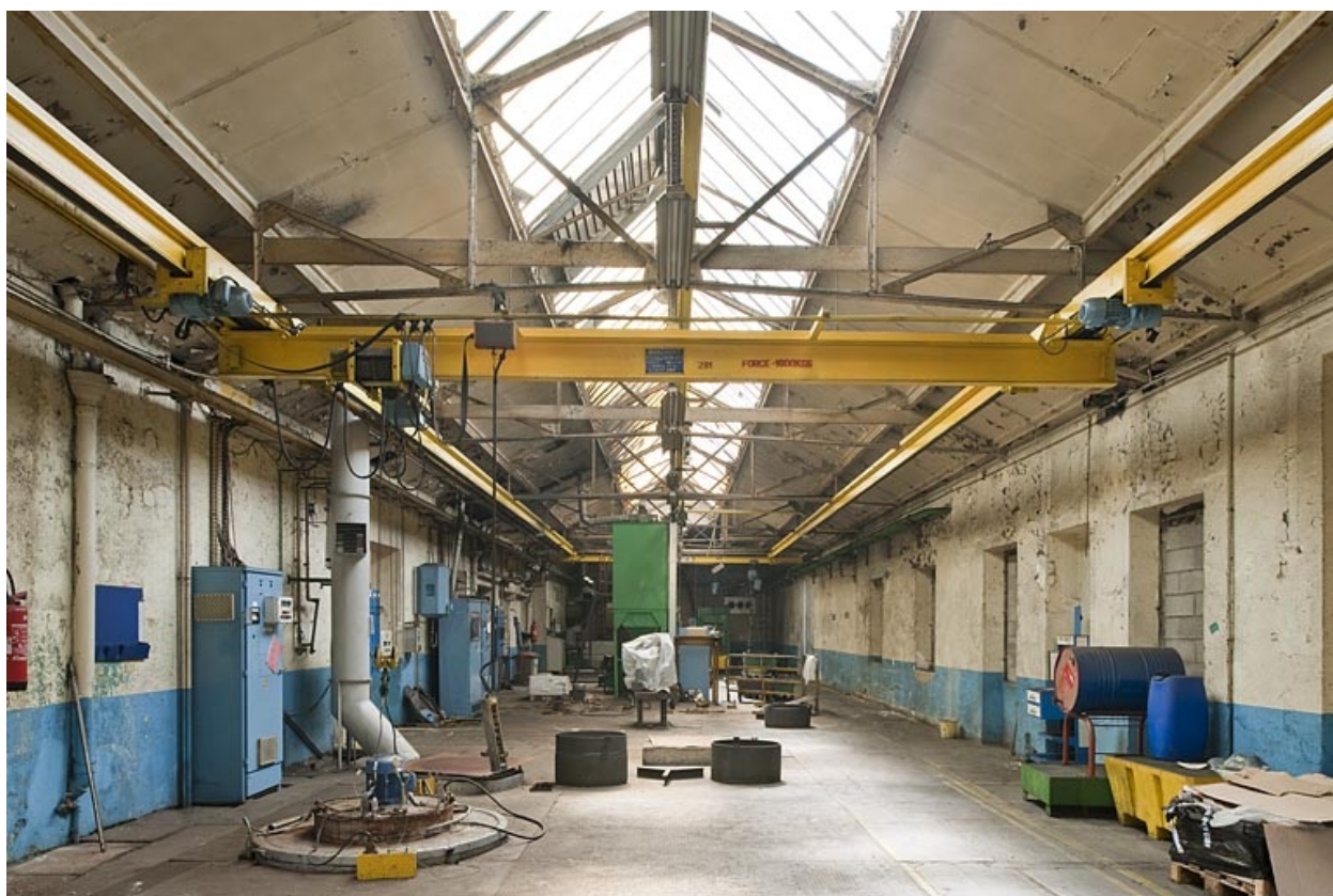
Atelier d'usinage nord. Travée orientale.
