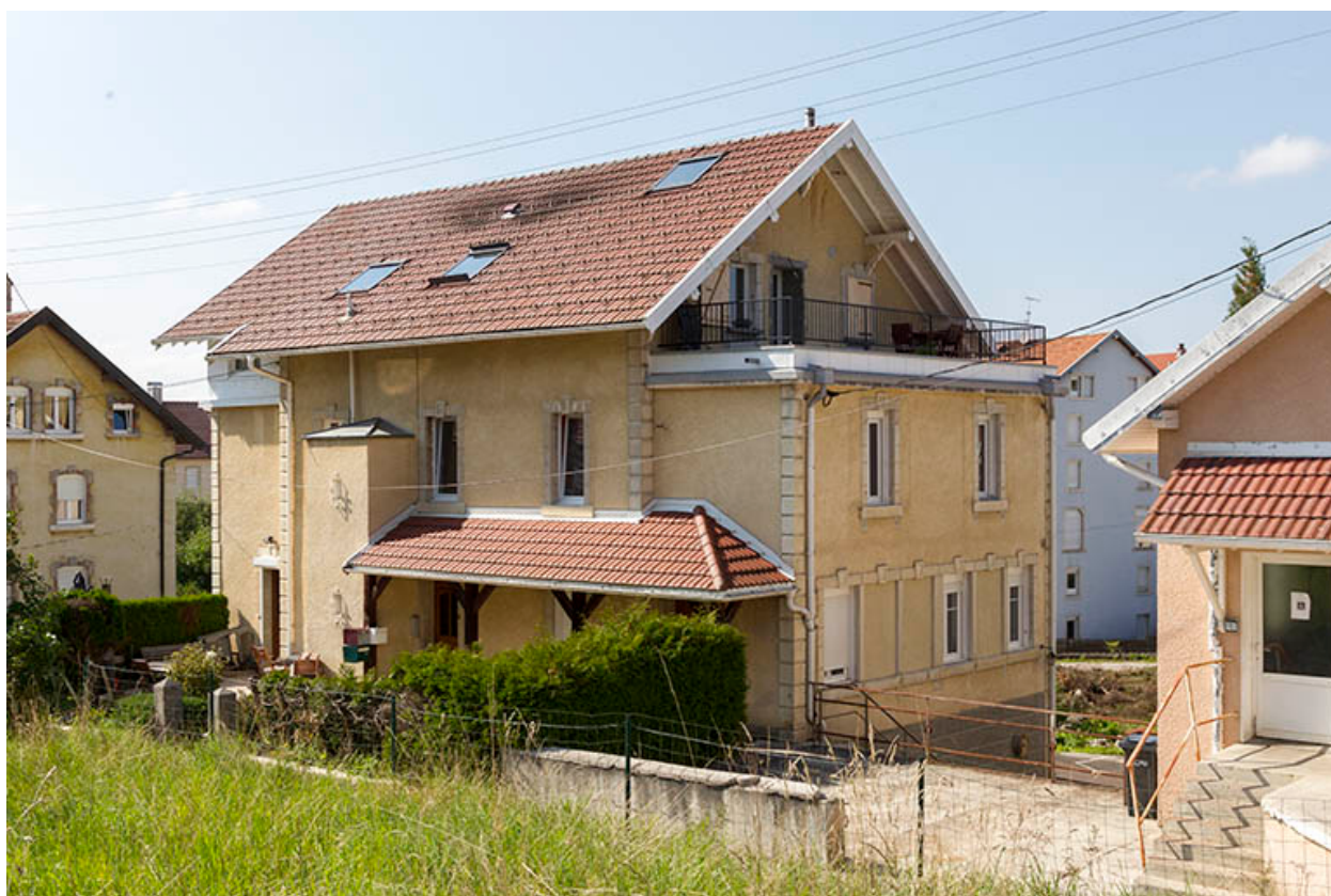
Maison : façades antérieure et latérale droite.
