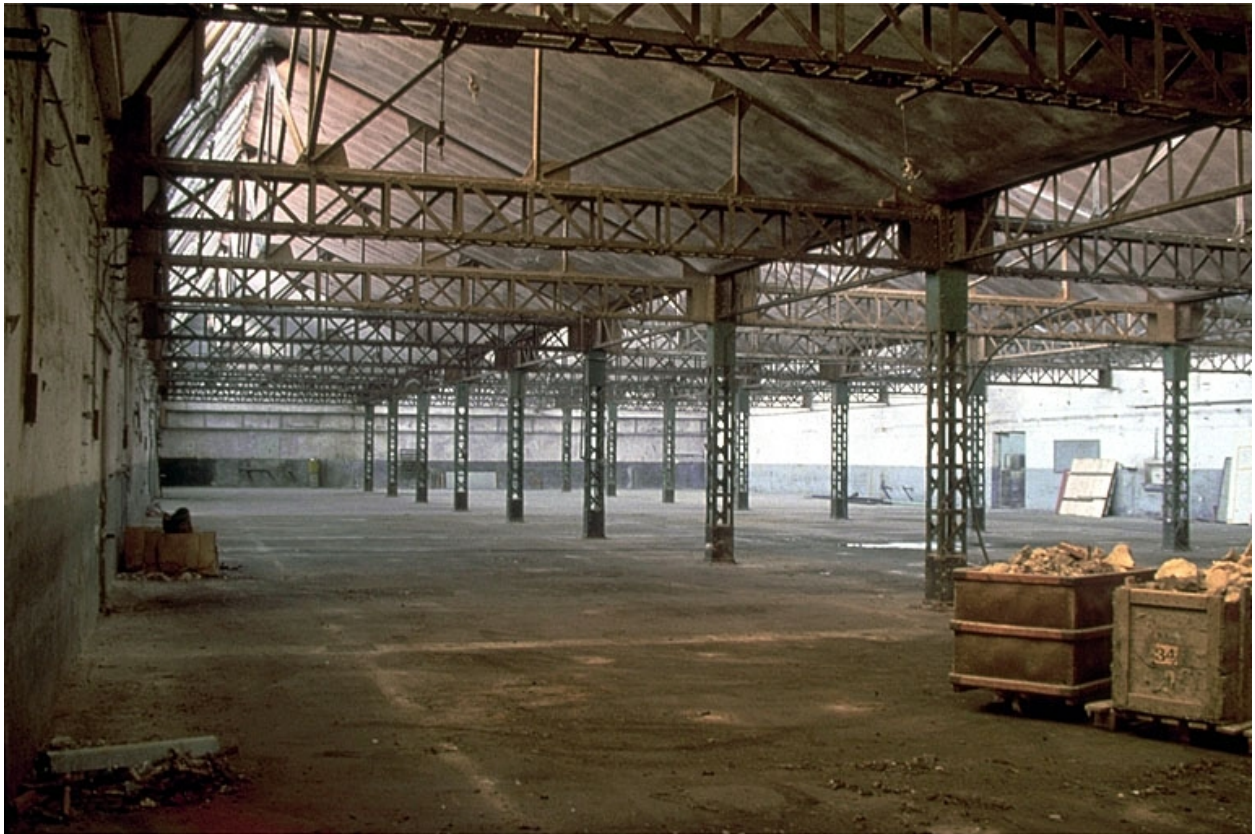
Atelier de fabrication (1), vu depuis l'angle nord-ouest.
