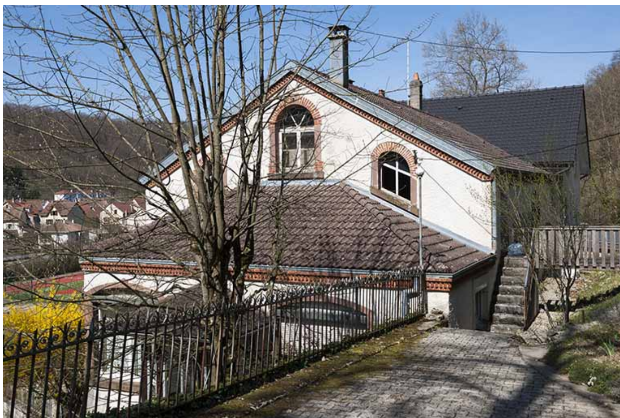
Pignon sud vu de trois quarts.
