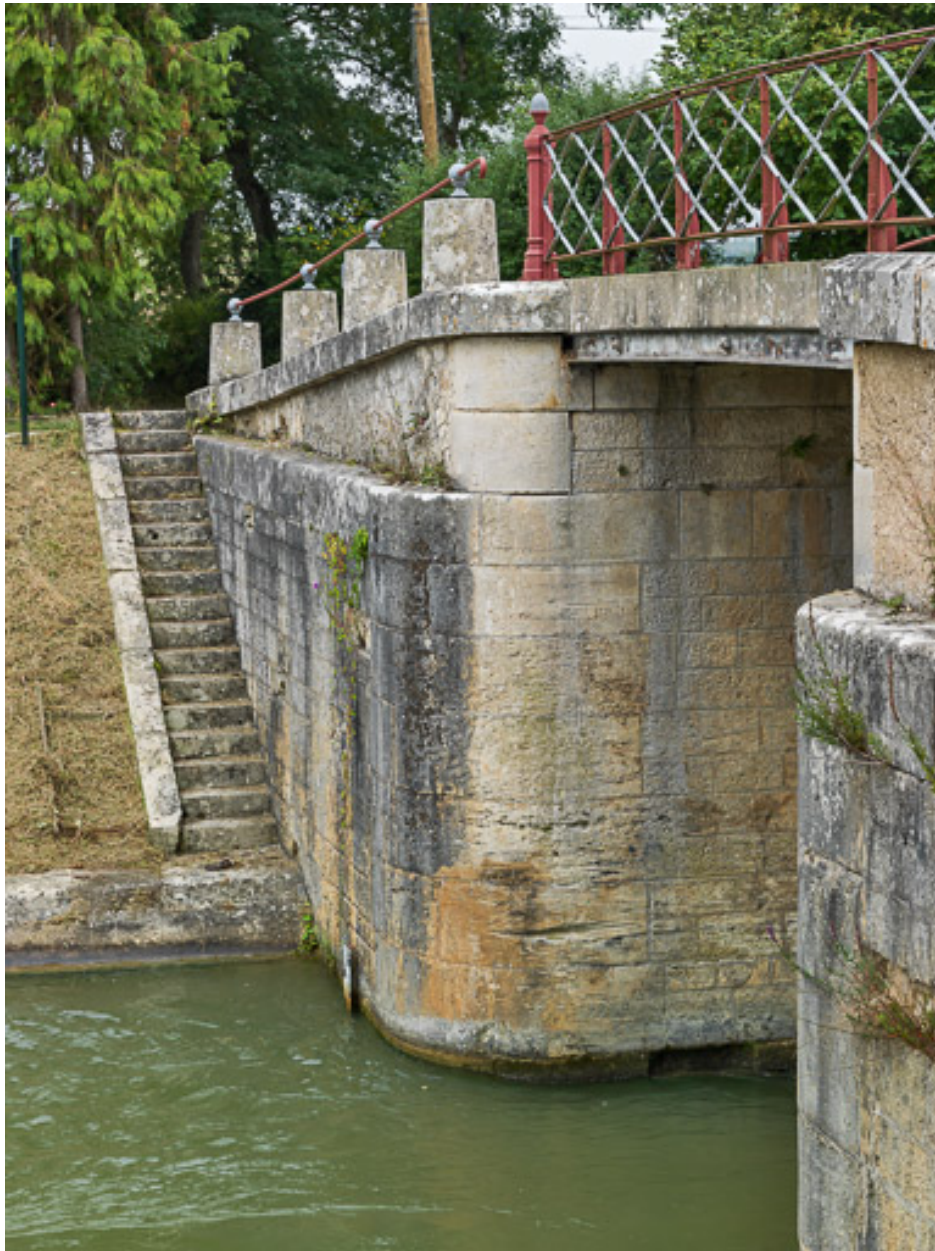
Vue des piles du pont.
