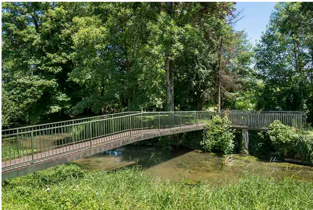
Passerelle au-dessus du ruisseau.
