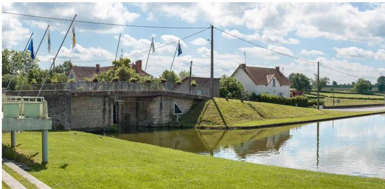
Le pont, vu d'aval.
