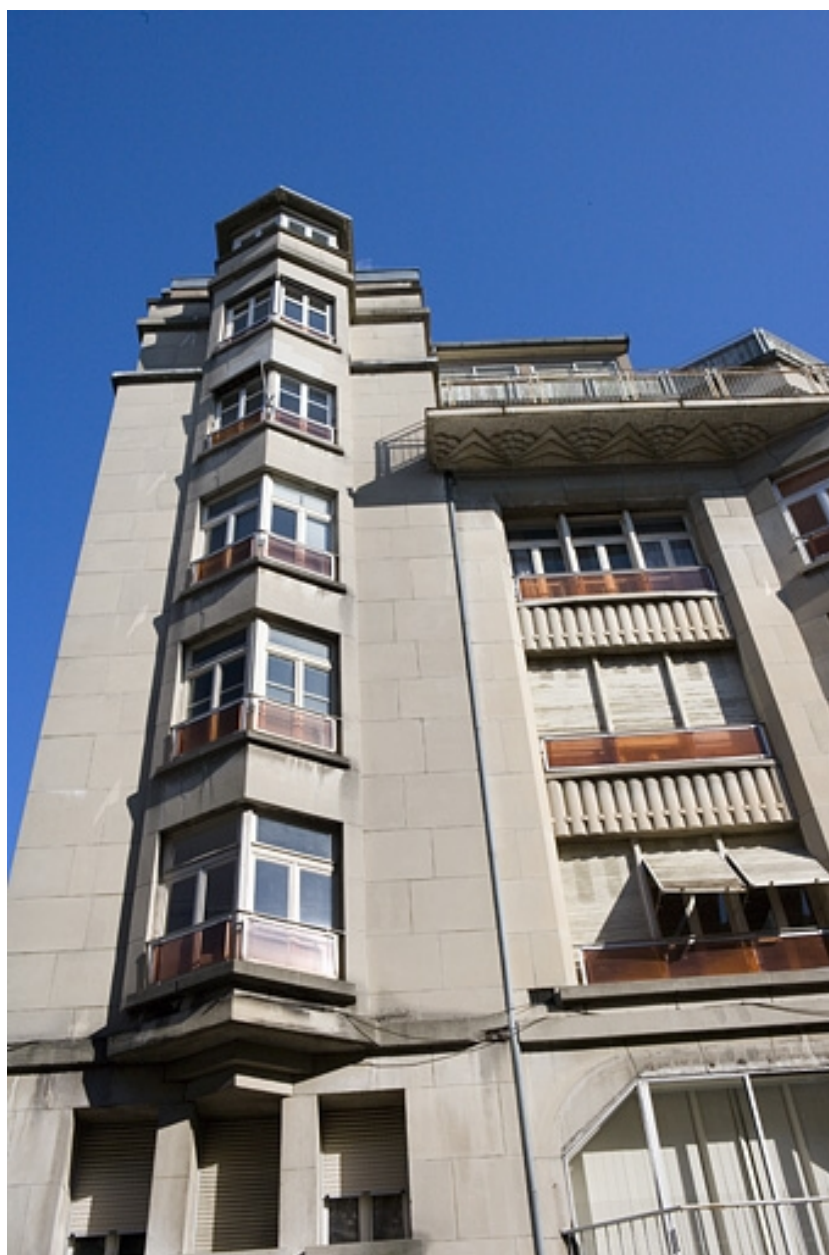
Façade antérieure : détail de la partie gauche.
