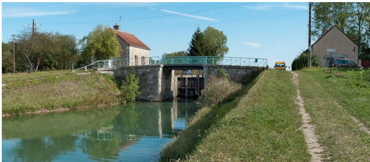
Le pont de l'aval.
