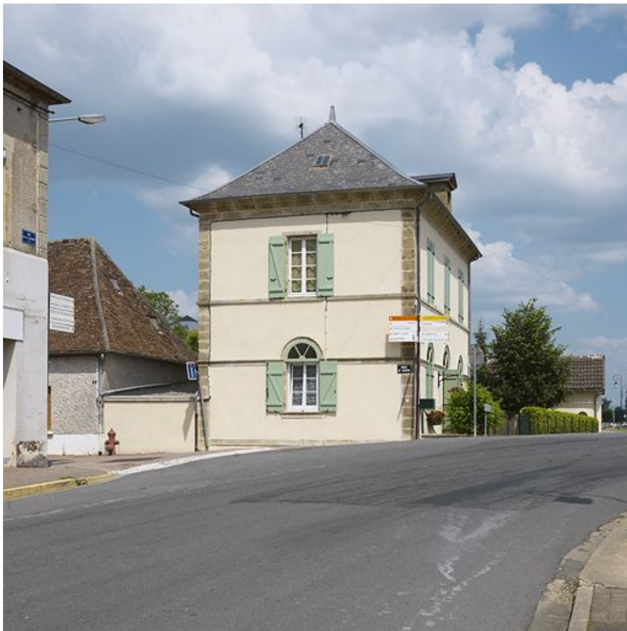
Façade latérale de la maison éclésièr.
