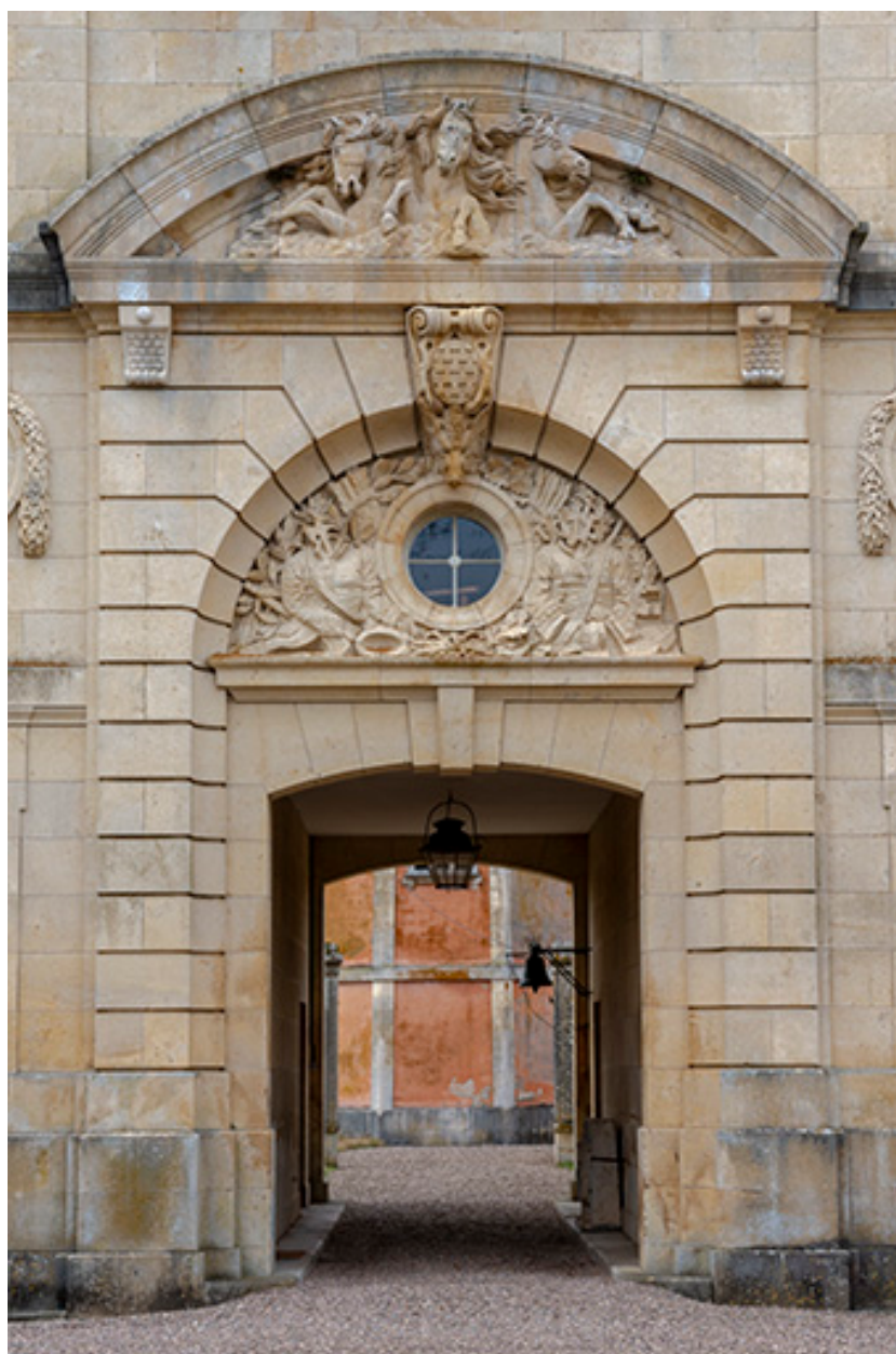
Portail à porte cochère du pavillon central.
