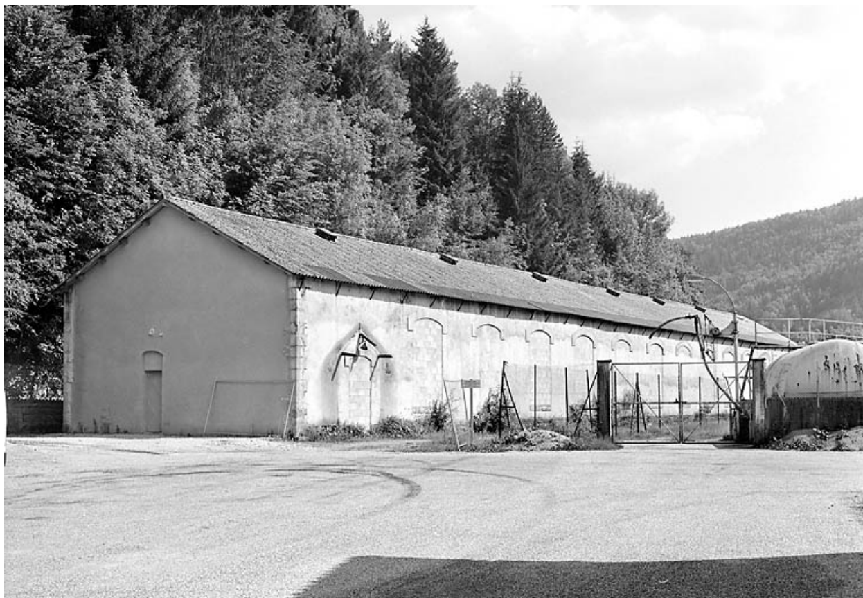
Remise ferroviaire, depuis le nord.
