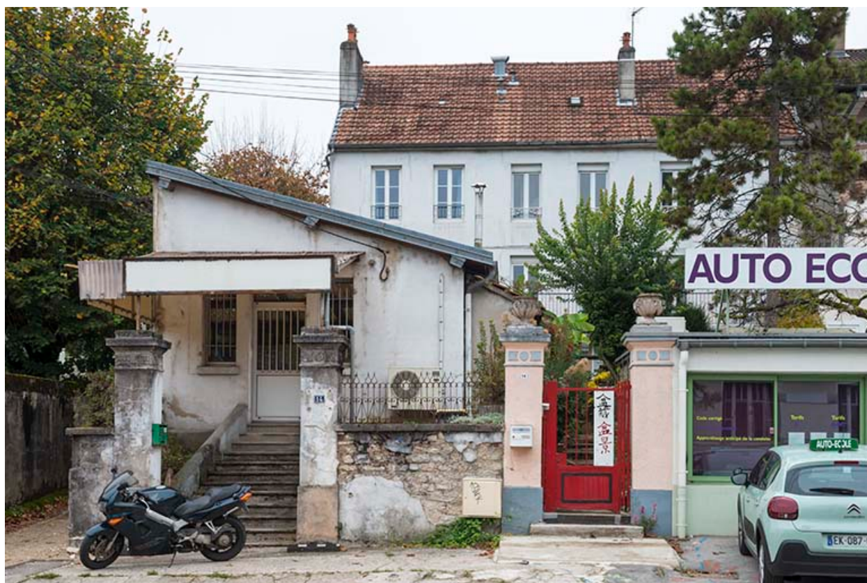
Vue d'ensemble depuis l'avenue.
