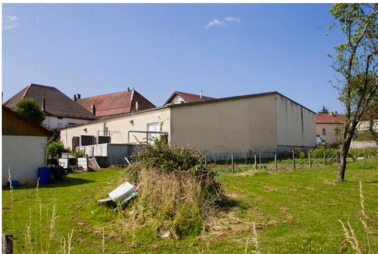
Façades postérieure et latérale gauche des extensions.
