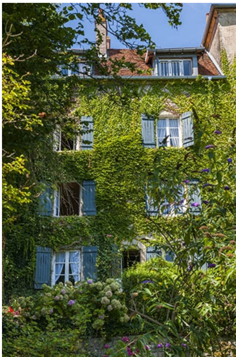
Façade postérieure, côté canal du Moulin.
