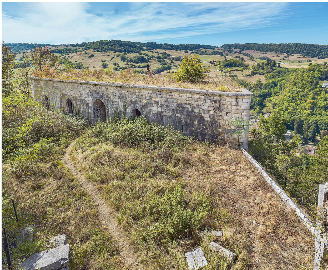
Le bâtiment casematé : façade postérieure.
