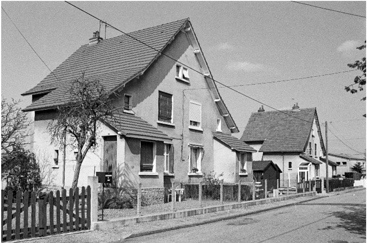
Bâtiment à logements " type 14 ", 1939-1945.
