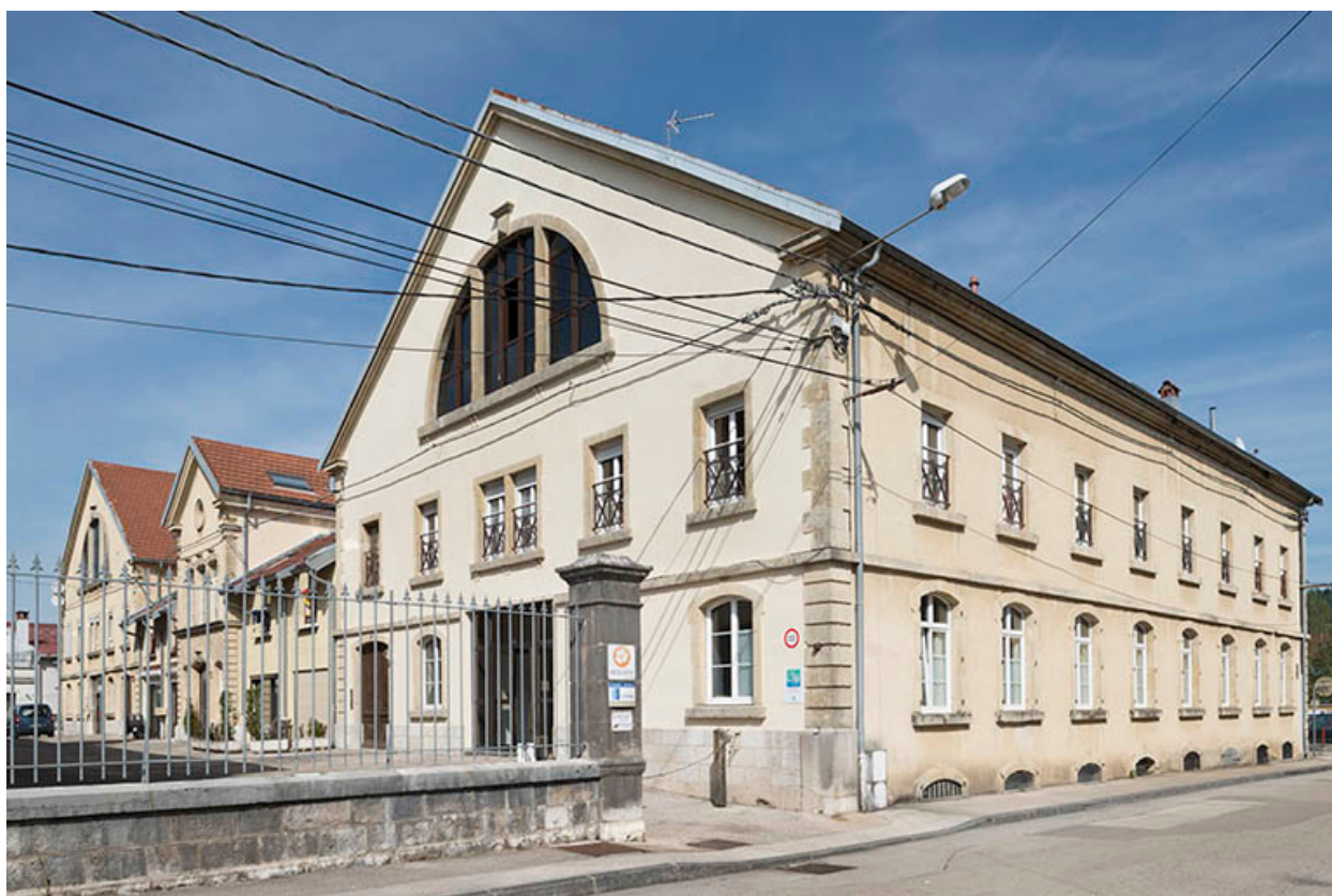
Pignons et façade sud des chais.
