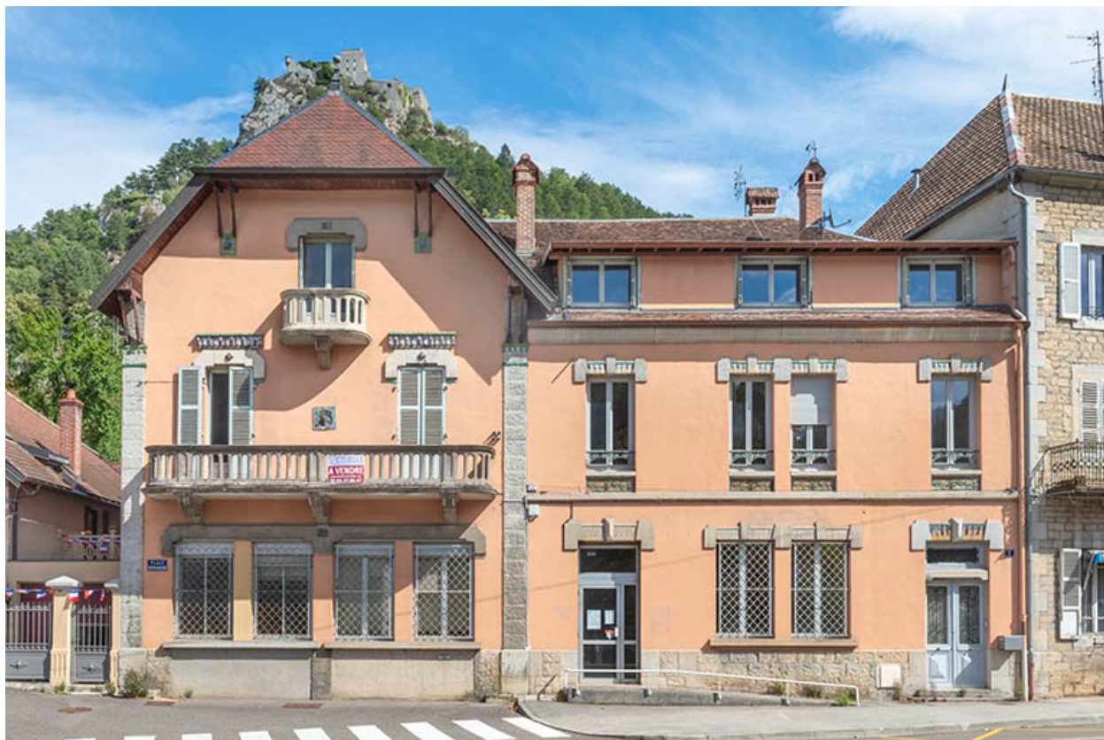
Vue de face (partie nord).
