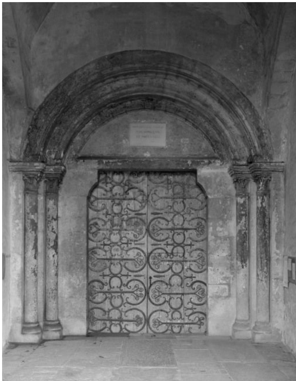
Eglise : porte antérieure de la nef.
