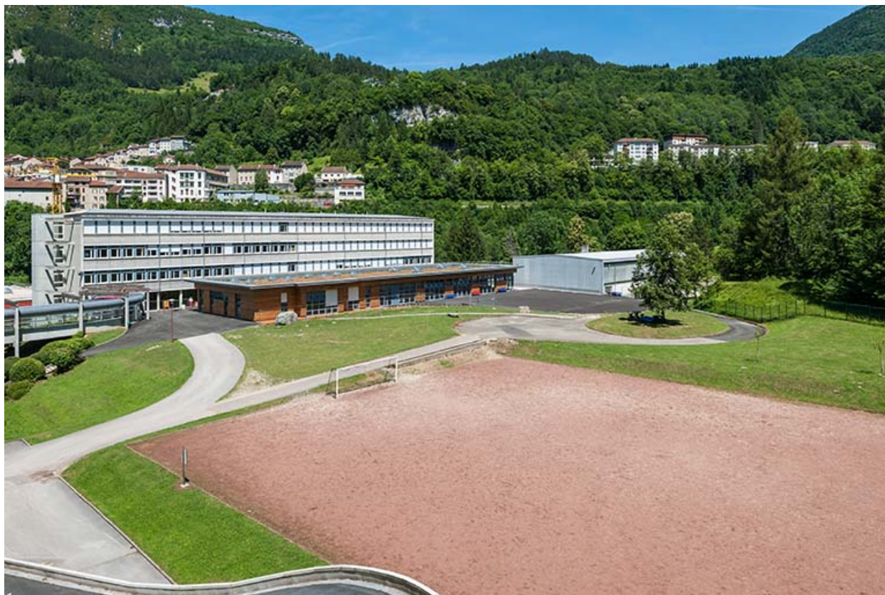
Externat : vue d'ensemble.
