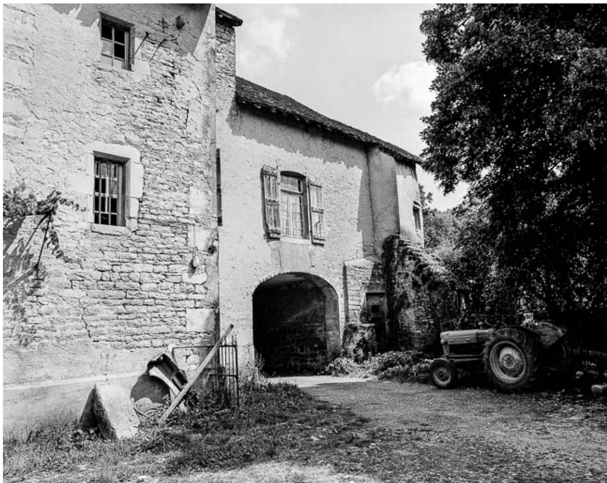
Porche d'entrée, élévation sur la cour.
