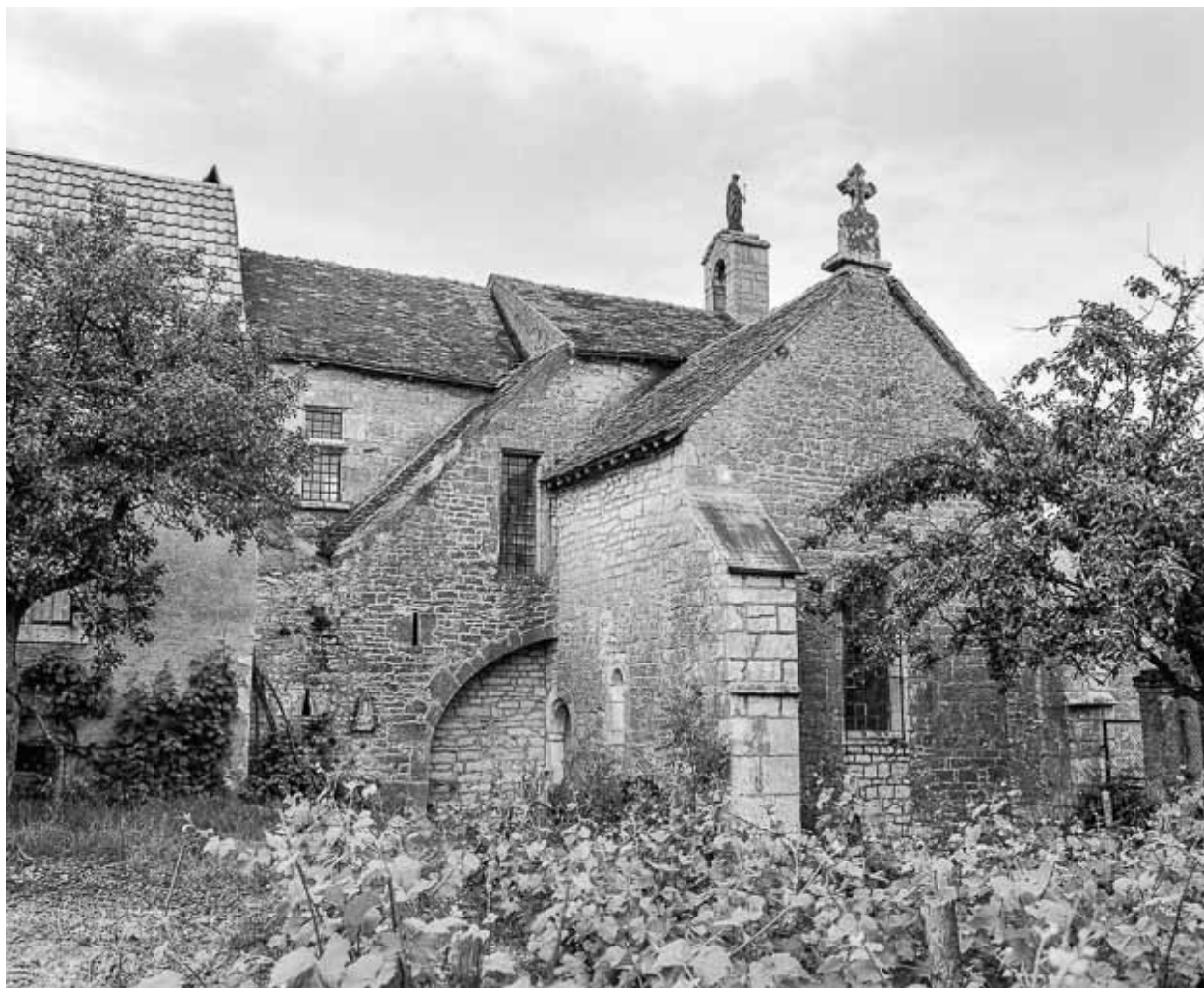
Extérieur : façade latérale droite.
