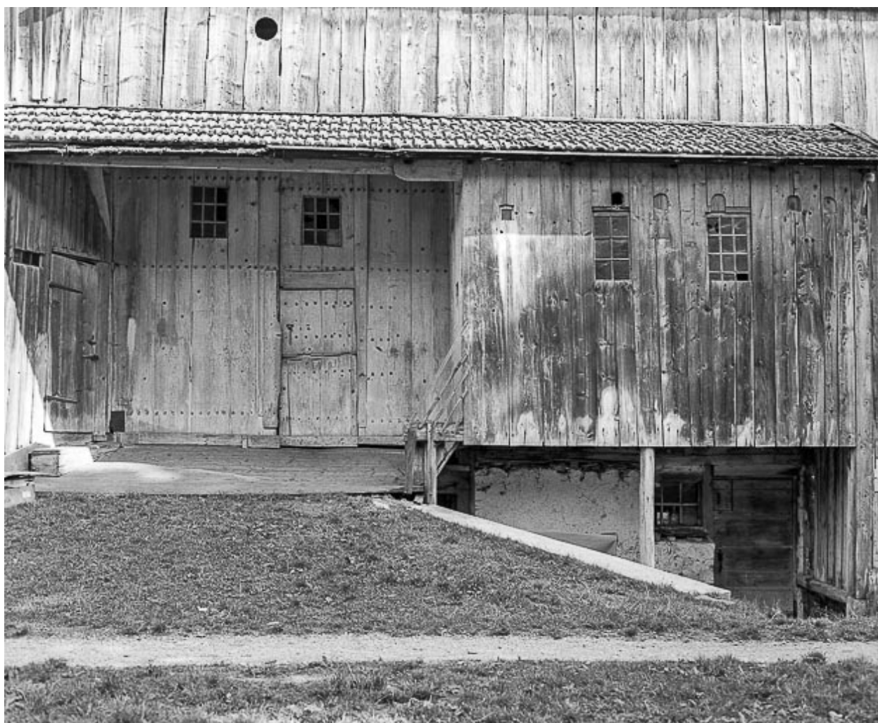
Façade postérieure en 1976 : détail.
