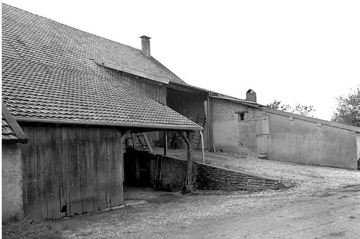
Façade latérale gauche : le pont de grange.
